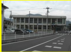
■提案事業(地域創造支援事業) 国分寺北部コミュニティセンター耐震改修
