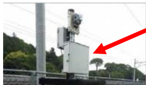
制御ボックス設置（例）
