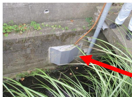
水位センサー設置 （例）
