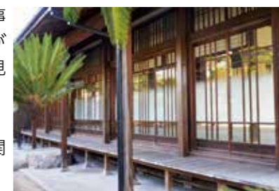
▲補強工事が完了した「蘇鉄の間」
