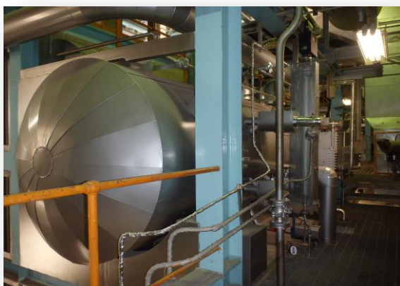
ボイラドラム(更新)
