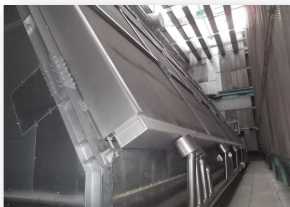
蒸気復水器(更新)
