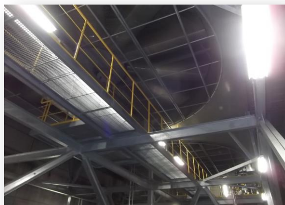
蒸気復水器(更新)
