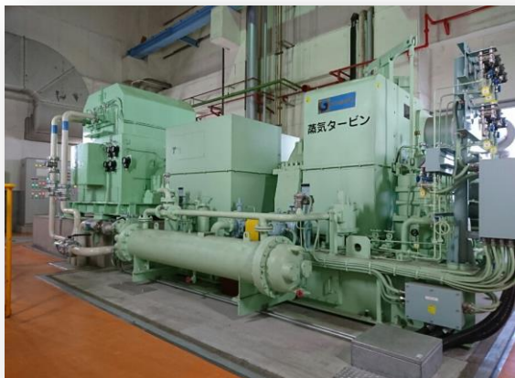
蒸気タービン発電機(更新)
