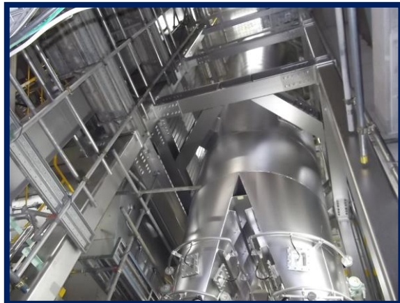
薬剤貯槽(改修後)
