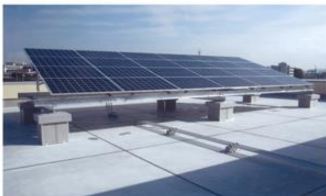
太陽光発電設備（牟礼支所・コミュニティセンター）
