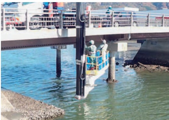
橋りょうの老朽化対策
