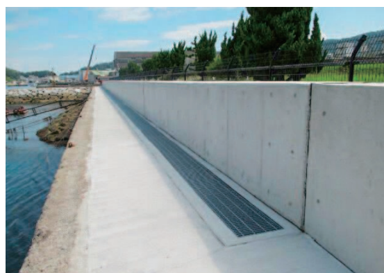
整備後の防潮壁(庵治港)
