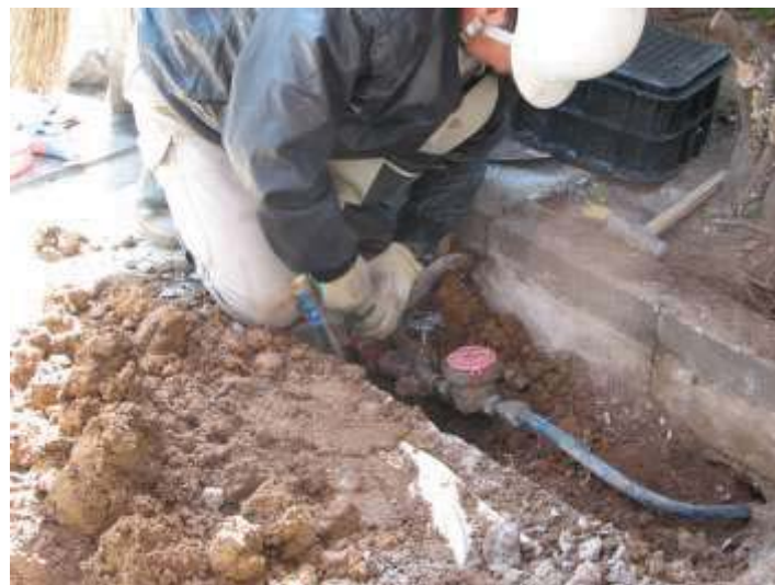
鉛管取替工事
