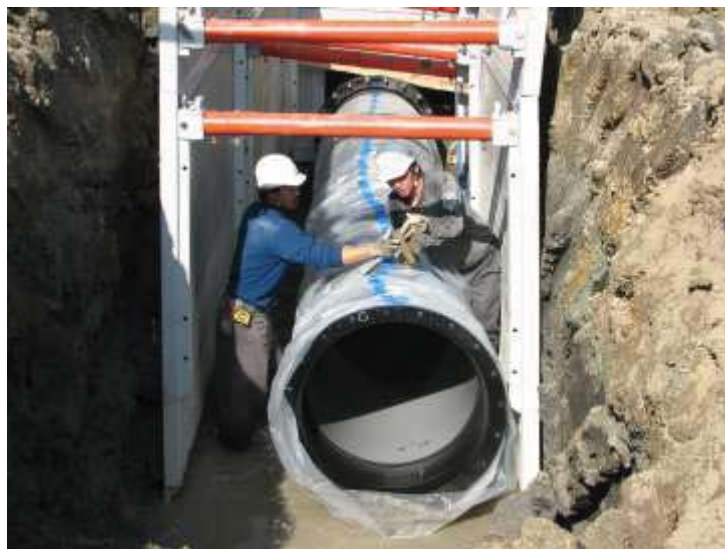
水道配水管布設工事
