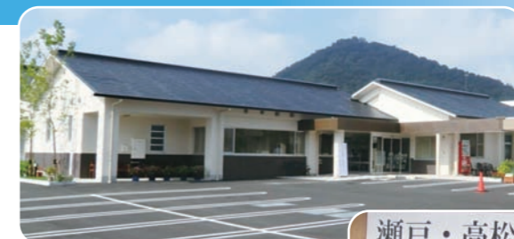
改築した コミュニティセンター
