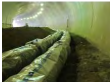
水道導配水管布設工事（木太鬼無線トンネル内）
