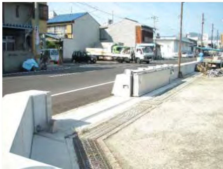
防潮堤（高松漁港）
