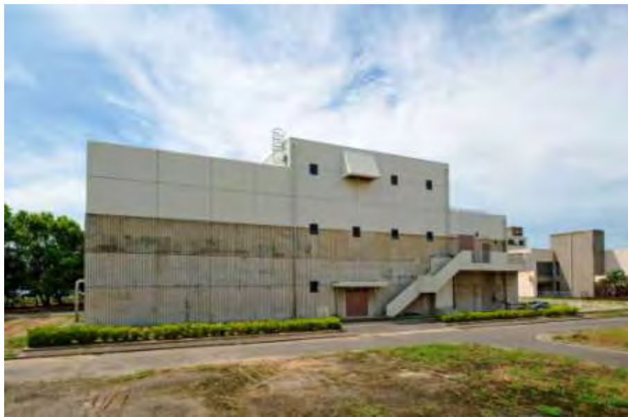
再生水処理施設
