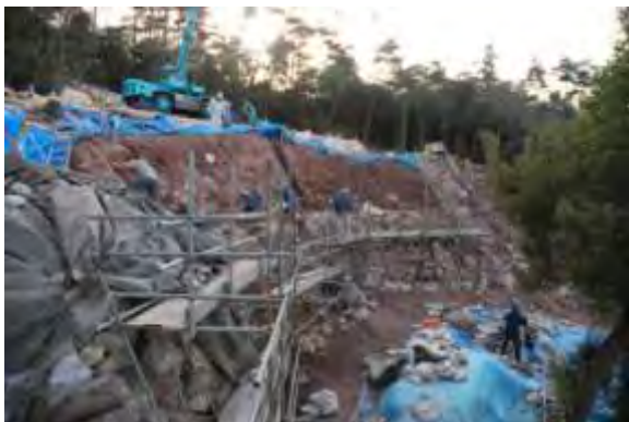
南側石垣解体状況
