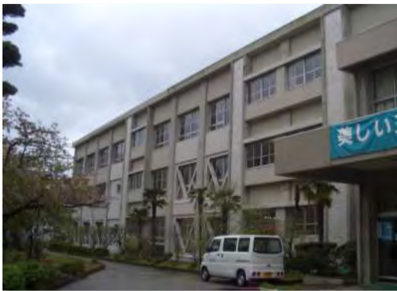
耐震化した校舎
