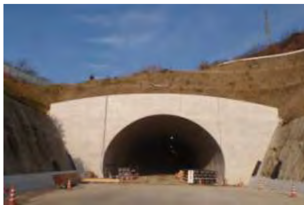
木太鬼無線（西春日工区）トンネル工事
