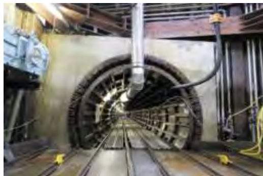
中部バイパス第3幹線工事（築地町）
