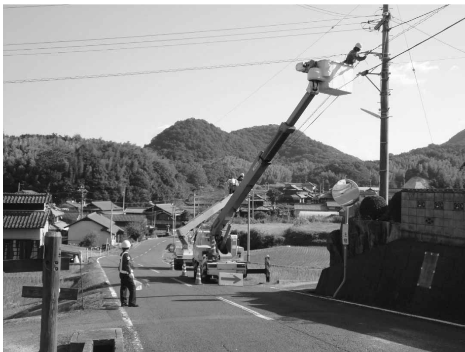
超高速情報通信網整備工事
