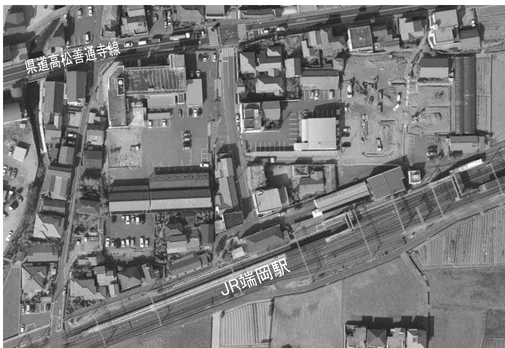
JR端岡駅北側回転広場整備
