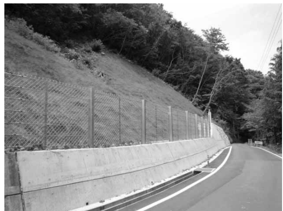
道路改良(県道穴吹塩江線)
