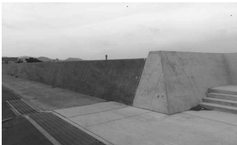
防潮堤（高松漁港胸壁）
