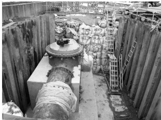
配水管布設工事（鹿角町）
