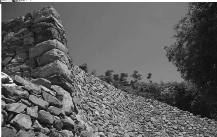
現在の屋嶋城城壁復元状況
