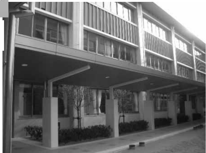
完成後の塩江小・中学校校舎
