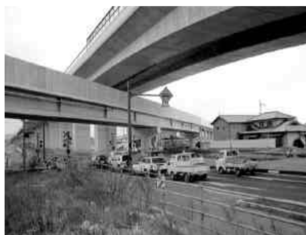
整備が進む長尾線高架橋
