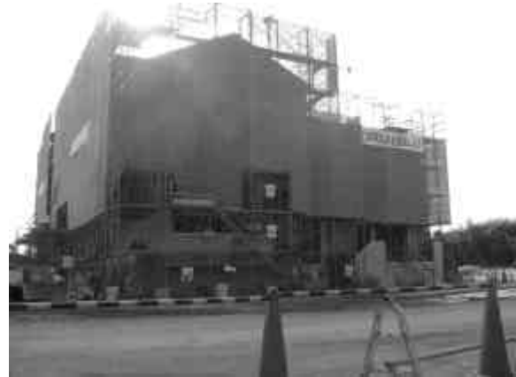
馬ノ口ポンプ場
