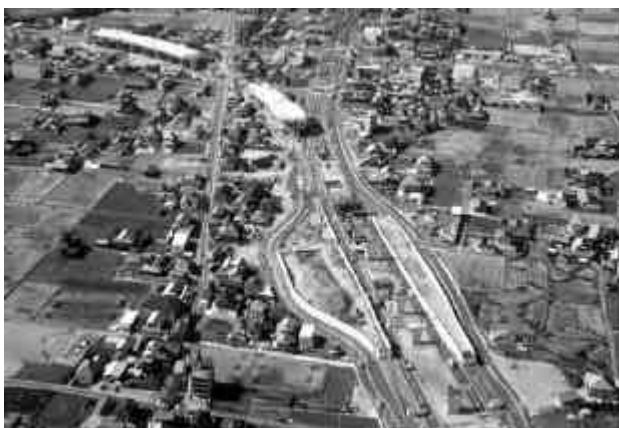
整備が進む高松檀紙（仮称）インターチェンジ
