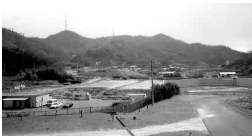
整備が進む東部運動公園（仮称）
