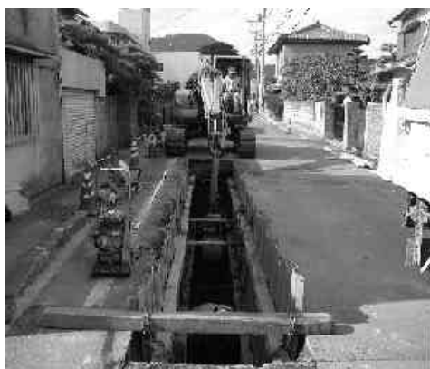
污水管渠開削工事
