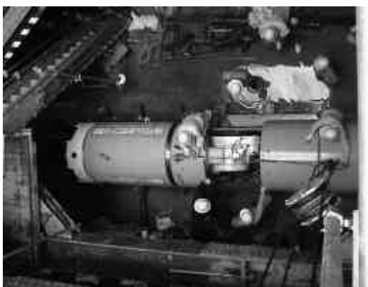
污水幹線工事(シールドマシン)
