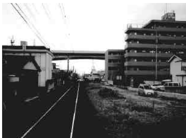
琴平線の高架工事に伴う仮線の整備予定地
