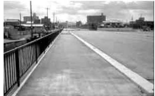
整備が進む福岡三谷線
