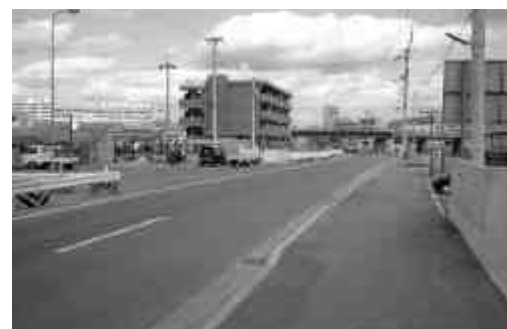
整備が進む朝日町仏生山線
