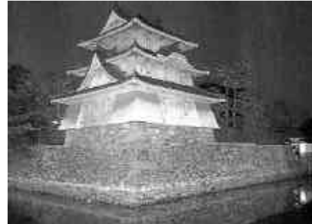
ライトアップされた良櫓（うしとらやぐら）
