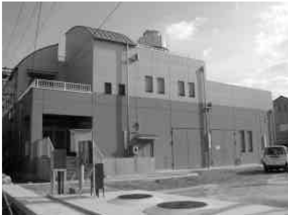
西部ポンプ場
