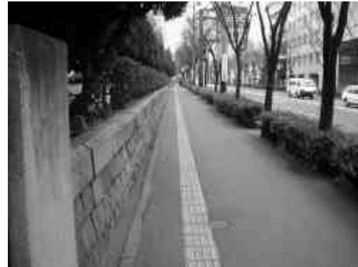
点字ブロック
