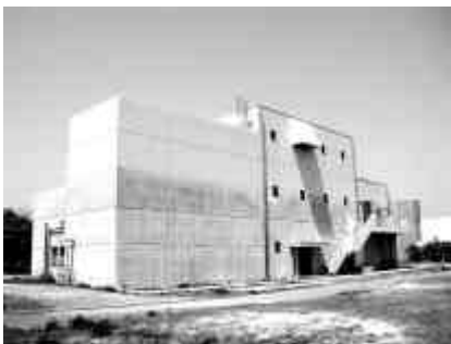
東部下水処理場内再生処理施設
