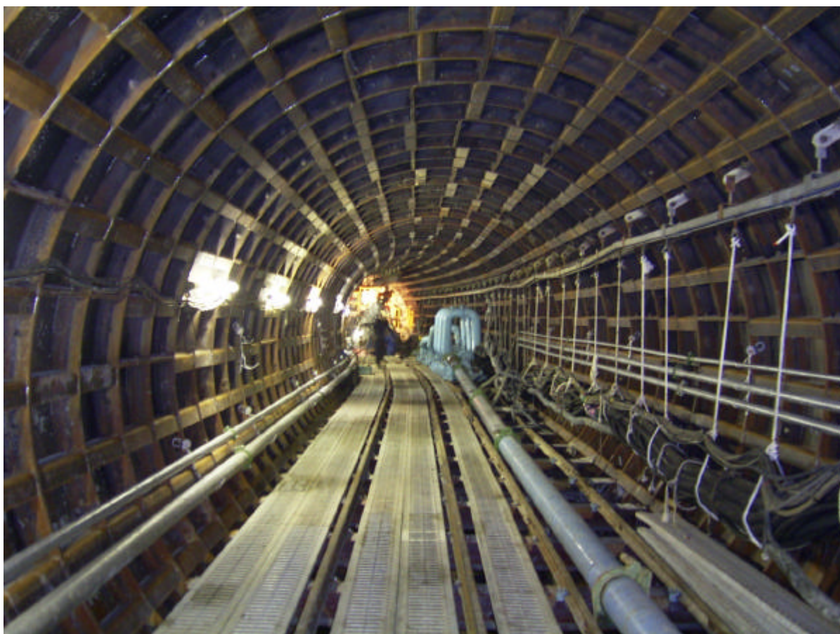
■中部バイパス第1幹線 施行中 抗内
