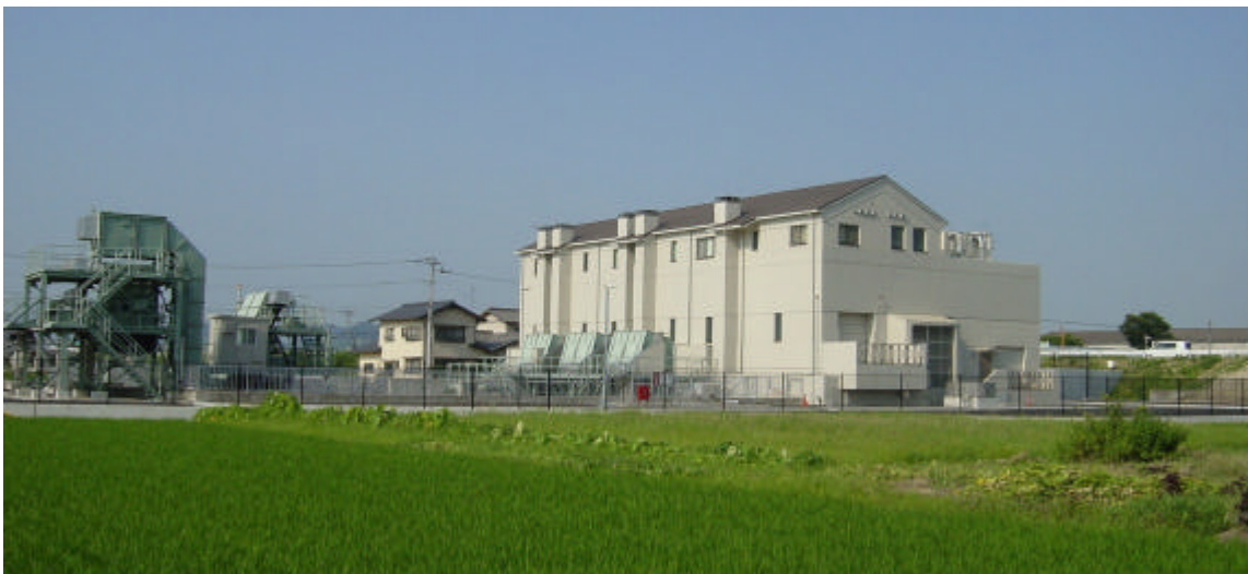
■馬ノ口ポンプ場（平成16年度完成）
