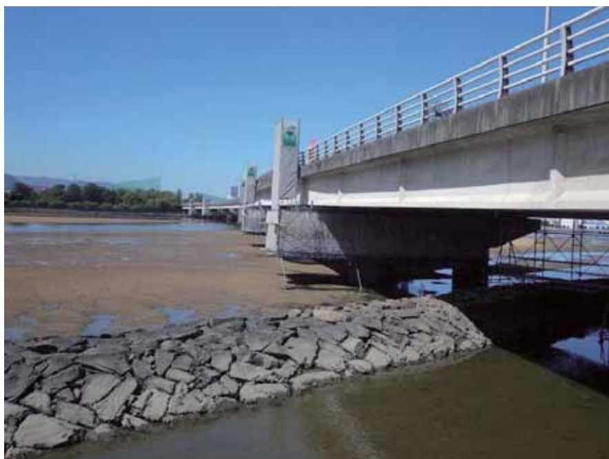
屋島大橋修繕状況
