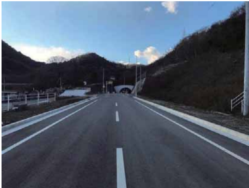
都市計画道路 木太鬼無線（西春日工区）整備状況
