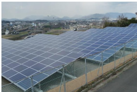
市有地貸出による太陽光発電事業（日生ニュータウン浄化槽跡地・香川町）
