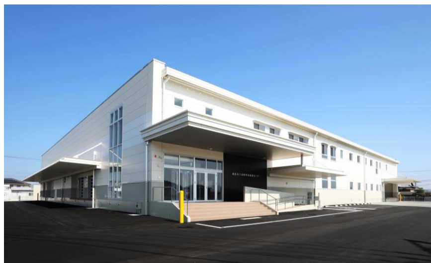
ドライ施設として整備した高松市六条町学校給食センター
