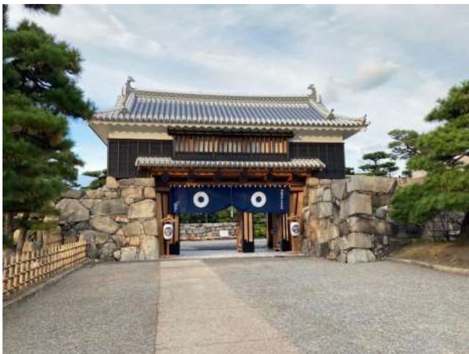
完成した桜御門
