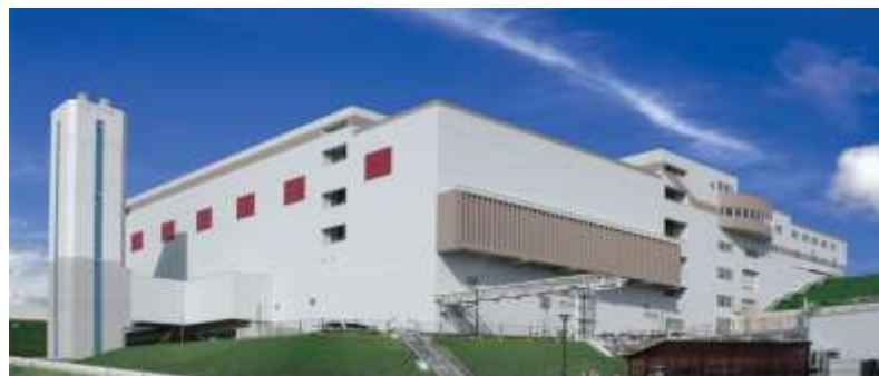
現在の南部クリーンセンター
