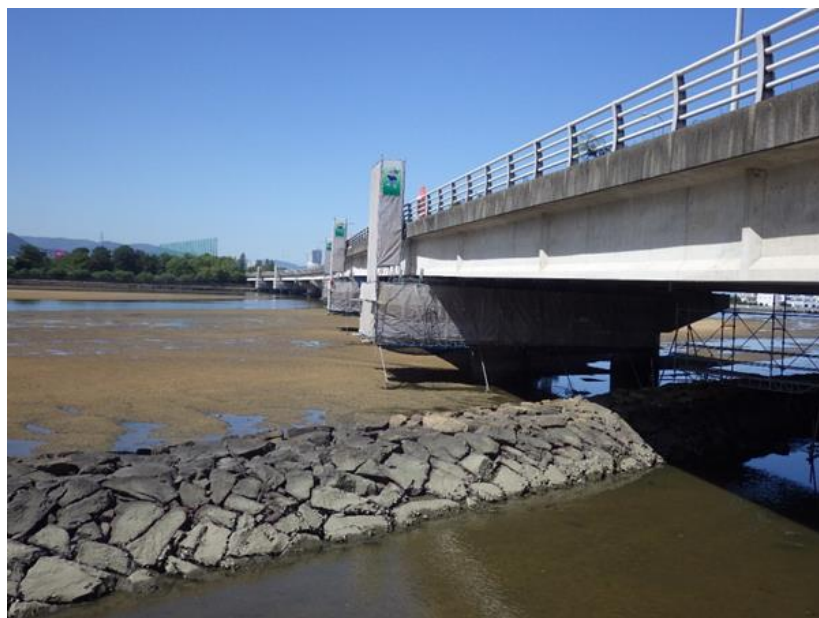
屋島大橋修繕状況
