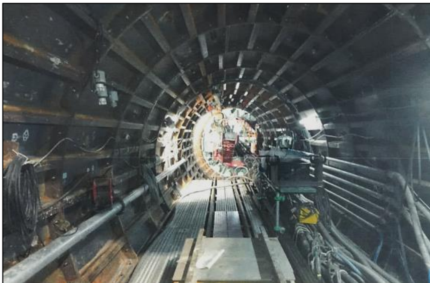
西部バイパス幹線工事
