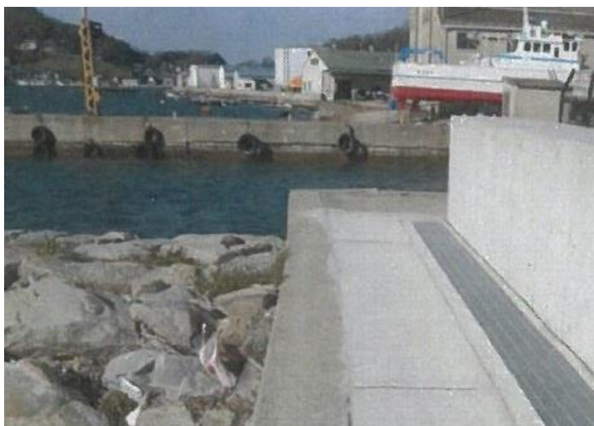
防潮壁(庵治港)
