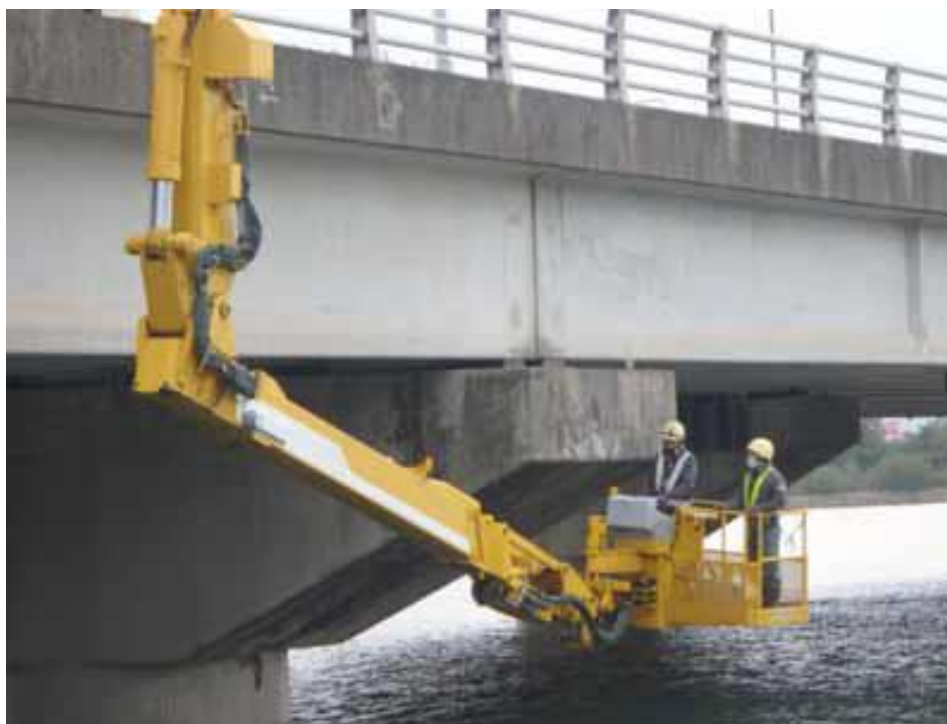
橋りょう点検
