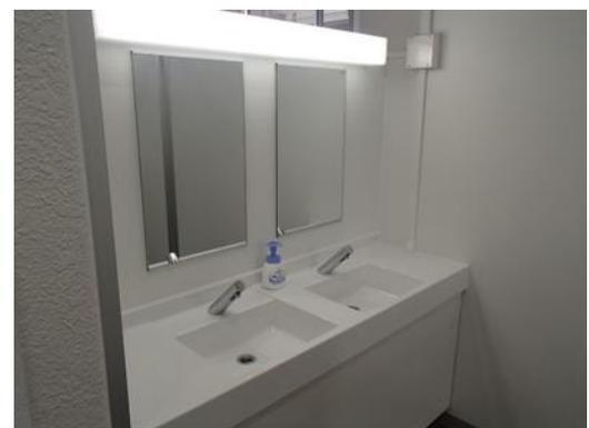
手洗い器の自動水栓化、照明器具のLED化
