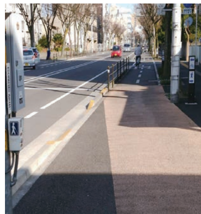
車道の幅員を縮小して整備された自転車道
