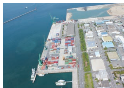
高松港コンテナターミナル施設
