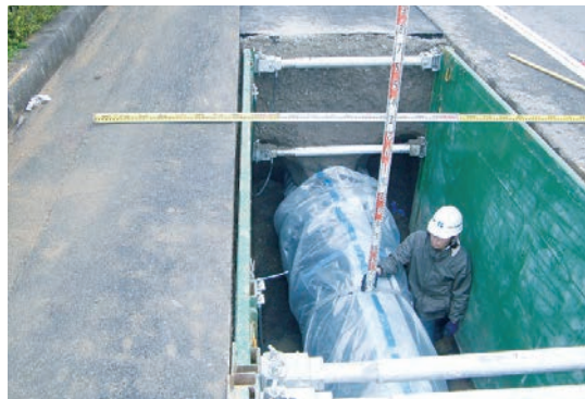
老朽配水管の更新及び耐震化
