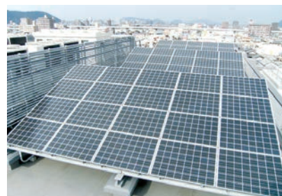
太陽光発電（東消防署屋上）
