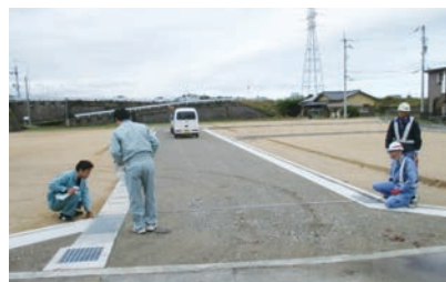
開発許可の工事完了検査
