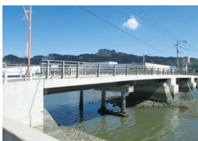
橋りょう（改修後）
