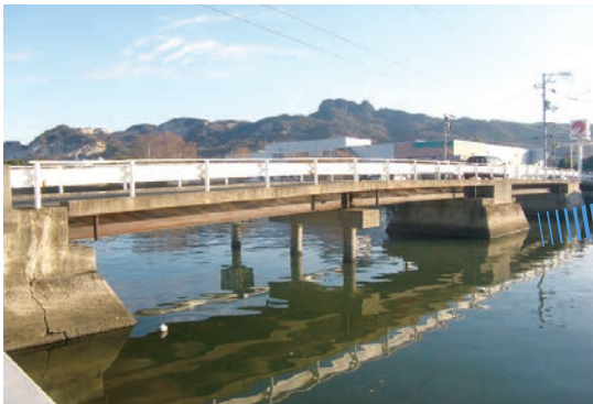
橋りょう（改修前）
