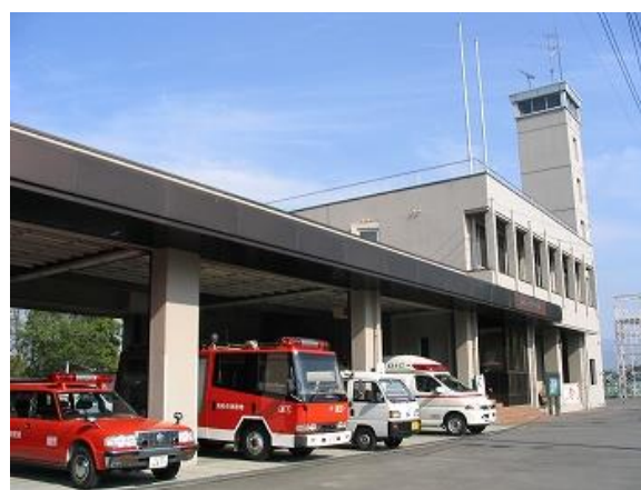
西消防署 綾川分署
