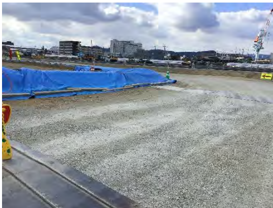
新青果棟建設現場 令和 3 年 1 月
