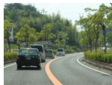
高松空港から中心部への道路景観
