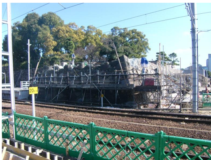
平成 26 年 2 月 3 日の地久櫓台
