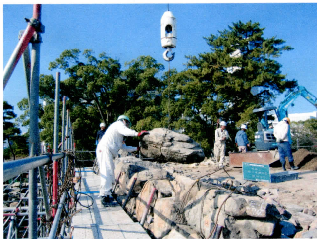
写真9 石垣解体状況
