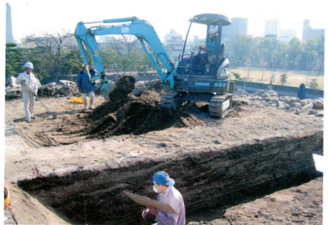
写真7 盛土掘削状況
