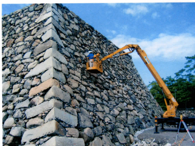
写真4 番付・墨打・外観調査状況
