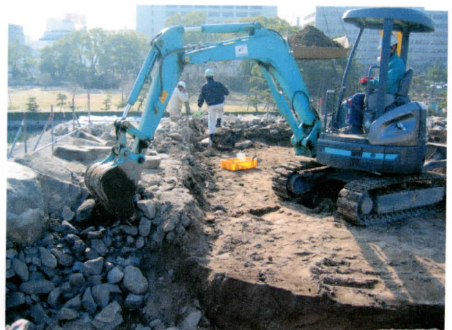
写真8 栗石掘削状況
