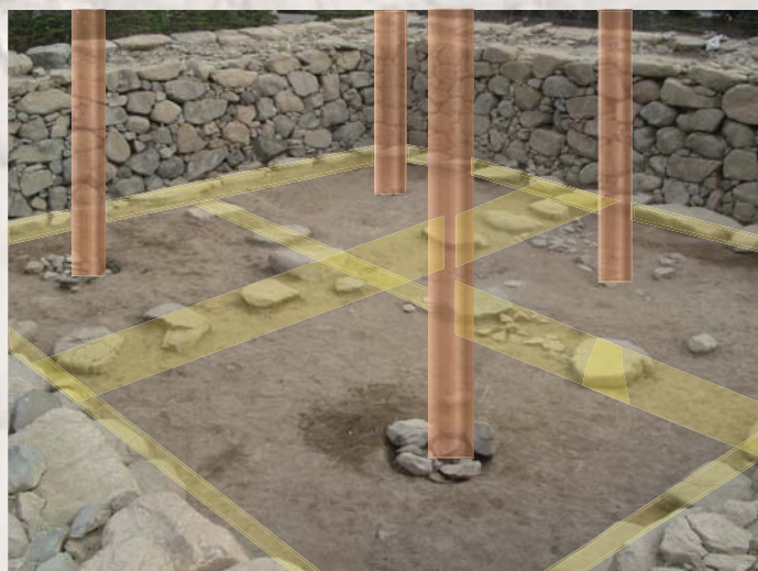
天守台地下1階掘立柱(茶色) + 礎石配置図(黄色)
