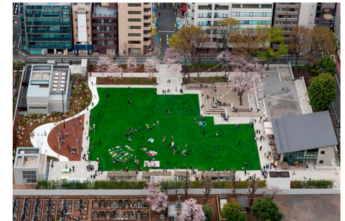
豊島区立南池袋公園【整備後】
