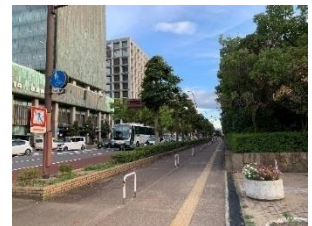
(東側) 国道 11 号 (中央通り)
