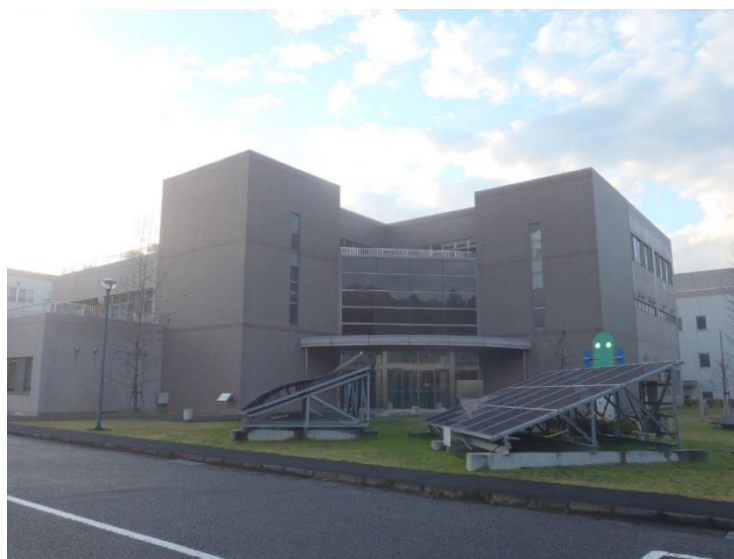
南部クリーンセンター
