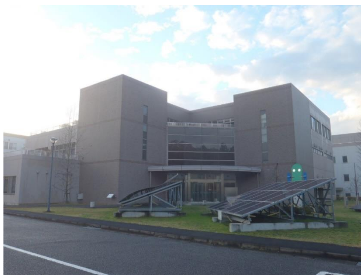
南部クリーンセンター
