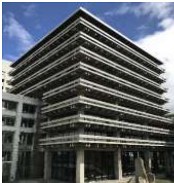
香川県庁舎旧本館
