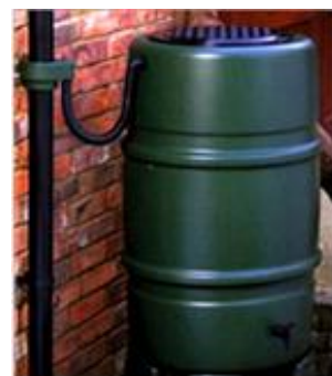
小規模貯留施設(雨水貯留施設)
