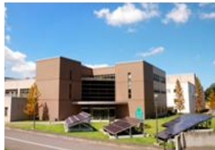
南部クリーンセンター
