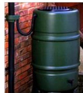
小規模貯留施設(雨水貯留施設)
