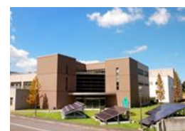
南部クリーンセンター
