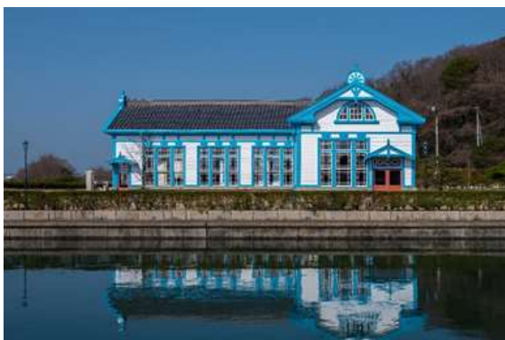
旧御殿水源地（高松市水道資料館） （建築物等に関するもの受賞作品）
