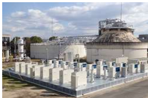
バイオマス発電設備
