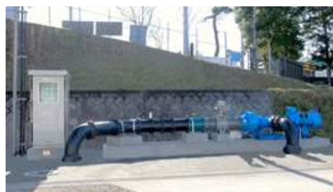
小水力発電設備
