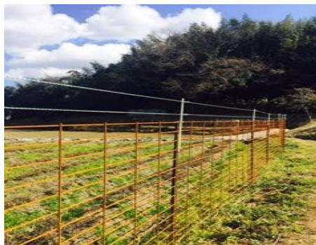
防護柵（電気柵）の設置
