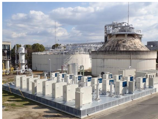
バイオマス発電設備
