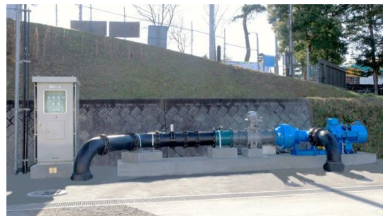
小水力発電設備
