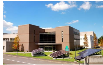
南部クリーンセンター
