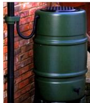
小規模貯留施設（雨水タンク）
