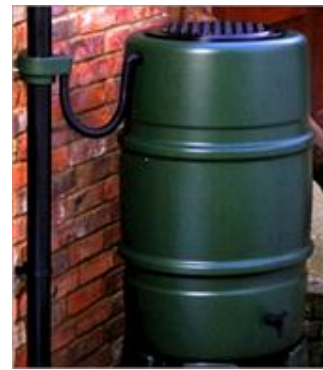
小規模貯留施設（雨水タンク）
