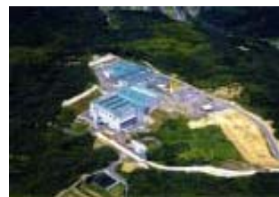
南部クリーンセンター
