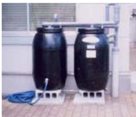
リサイクル製品の雨水タンク
