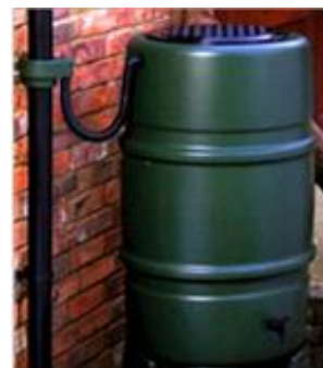
小規模貯留施設（雨水貯留施設）
