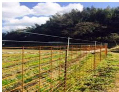
防護柵（電気柵）の設置
