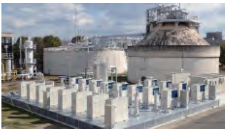
▲バイオマス発電設備(東部下水処理場)
