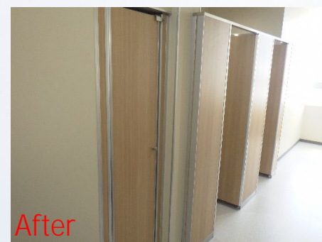
校舎棟 女子トイレ
