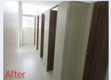
校舎棟 女子トイレ
