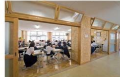
様々な学習内容・学習形態に対応できる多目的スペースを整備
