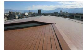
耐久性に優れた屋根材の一例 (カラーガルバリウム鋼板)
